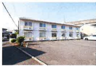
イーリス I 外観
